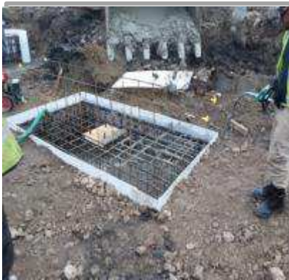
Concrete pour on 4 cap pile.
